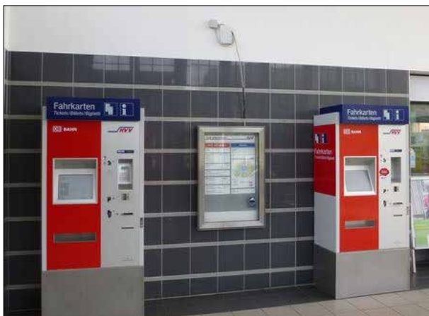
Abbildung 33: Die Verlegung des Stromanschlusses dieser Vitrine in Aumühle sieht unprofessionell aus.
