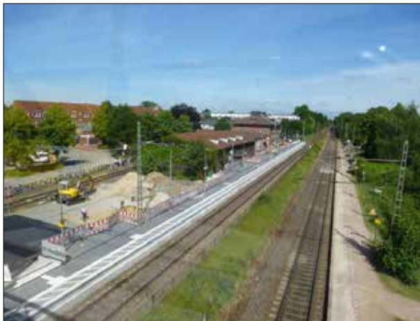
Abbildung 5: Während der Bahnsteig an Gleis 1 in Tornesch erneuert wurde, ist der Zustand des Bahnsteigs an Gleis 2 weiterhin mangelhaft.
