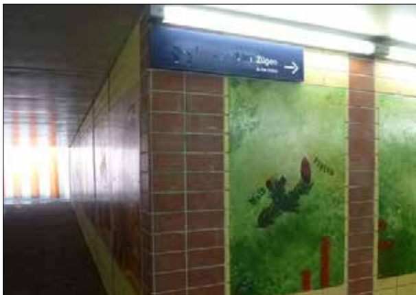
Abbildung 25: Die Schilder im südlichen Tunnel in Halstenbek sind durch häufiges Reinigen nicht mehr lesbar.
