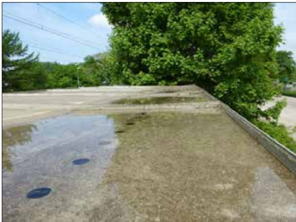
Abbildung 8: Ein Blick auf das Dach des Unterstands an Gleis 2 in Jübek lässt erkennen, dass der Wasserablauf verstopft ist. Folge davon sind in den Unterstand tropfendes Wasser und eine vermooste Regenrinne.
