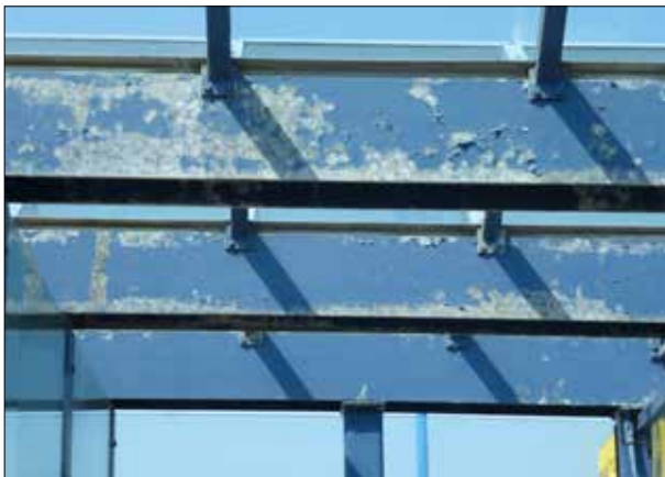
Abbildung 9: Die Träger des Unterstands am Bahnhof Dagebüll Mole weisen Lackschäden auf.
