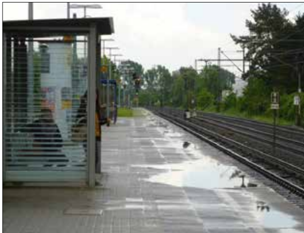
Abbildung 4: In Thesdorf bilden sich besonders in der Nähe der Bahnsteigkanten große Pfützen.
