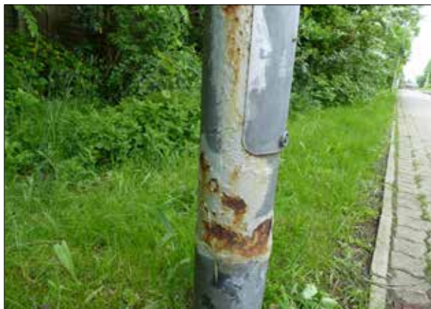
Abbildung 48: Einige Lichtmasten in Nortorf sind deutlich angerostet.
