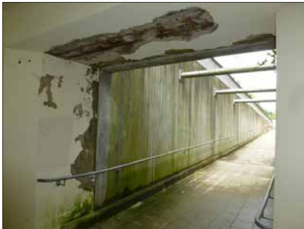
Abbildung 43: Neue Schäden wurden am Übergang des Tunnels zur Rampe zu Gleis 2 in Bad Schwartau verzeichnet.
