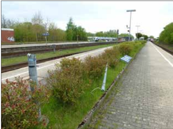
Abbildung 46: In Husum ist ein Lichtmast auf dem Bahnsteig der Gleise 1/3 abgebrochen.
