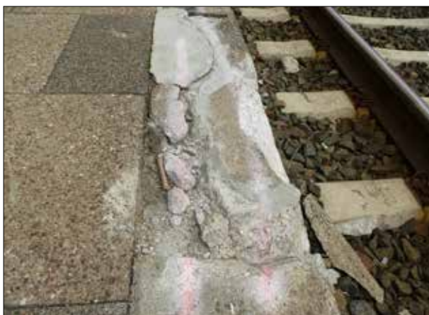
Abbildung 2: Umfangreiche Schäden waren an der Bahnsteigkante des Gleis 1 in Flintbek zu verzeichnen.
