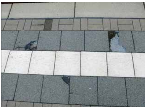
Abbildung 6: Auf dem Bahnsteig in Wiemersdorf waren einige Platten des Kontraststreifens beschädigt.
