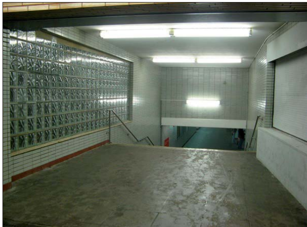
Abbildung 43: Durch die Erneuerung beschädigter Glasbausteine und Graffitibeseitigung wurde der Zugang Quellental in Pinneberg deutlich aufgewertet.
