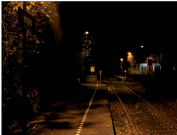
Abbildung 4: Der Bahnsteig Richtung Bad Oldesloe in Altengörs wurde an der Kante instand gesetzt und scheint wieder stabil zu sein.
