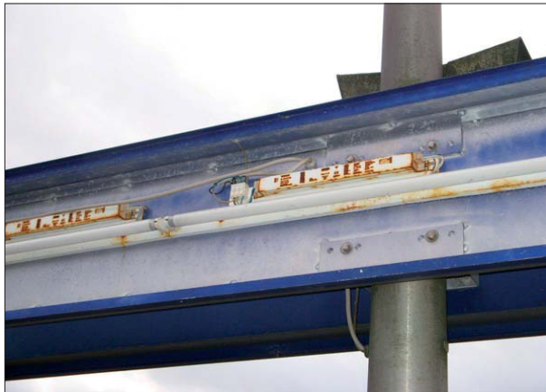
Abbildung 55: Durch mehrere Monate beschädigte und dann fehlende Abdeckung ist das elektrische Innenleben dieses Stationsschildes in St. Michaelisdonn angerostet.
