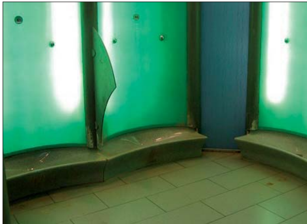
Abbildung 38: Deutliche Korrosionsschäden gibt es an den Urinalen in Westerland. Außerdem war ein Herren-WC gesperrt.
