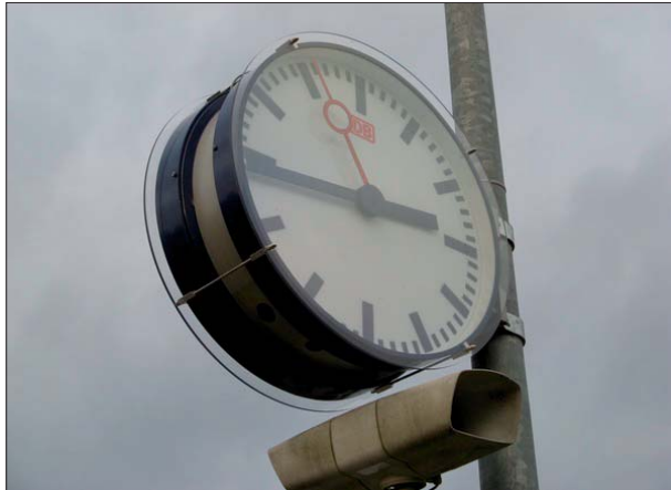
Abbildung 19: Bewährt hat sich die hier in Rickling zu sehende zusätzliche Abdeckung der Uhren gegen Vandalismusschäden.
