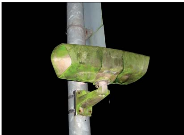
Abbildung 27: Felde gehört zu den Stationen, an denen einige Lautsprecher weiterhin extrem schmutzig sind.
