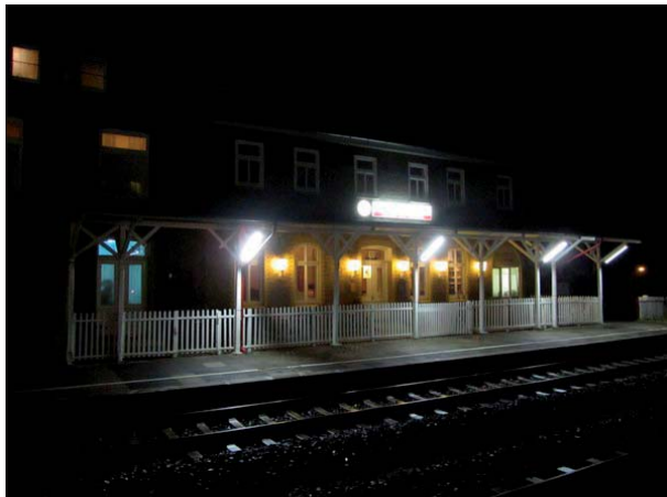
Abbildung 46: Die neue Bahnsteigbeleuchtung am Vordach des Gebäudes in Flintbek hat zu einer deutlichen Verbesserung der Situation geführt.
