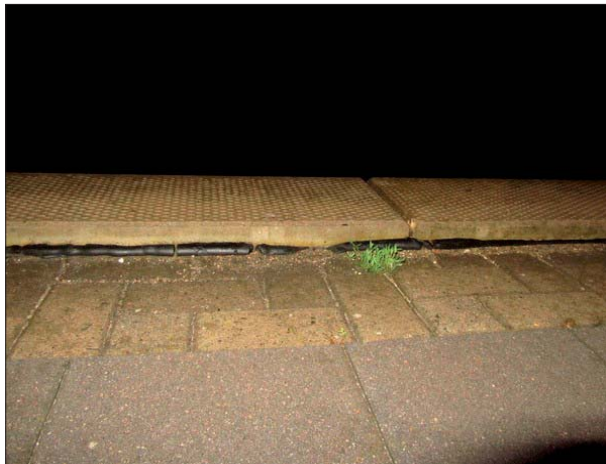
Abbildung 4: Wie hier in Kremperheide sind an vielen Bahnsteigen die Pflastersteine vor der Bahnsteigkante abgesackt, so dass Stufen entstehen.
