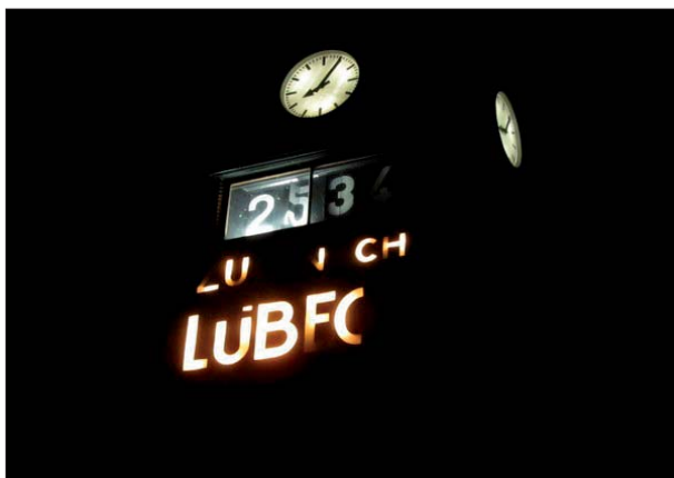
Abbildung 18: An der Abfahrtsanzeige am Turm des Bahnhofs Travemünde Strand mussten Mängel bei der Stundenanzeige und bei der Beleuchtung der Buchstaben notiert werden.
