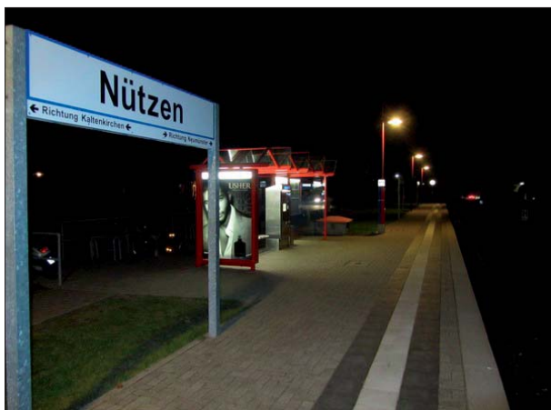
Abbildung 6: Zum Beseitigen der Unebenheiten wurde der Bahnsteig in Nützen neu gepflastert. Dabei wurde auch ein Blindenleitstreifen eingerichtet.
