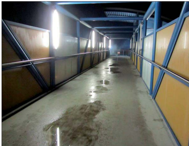
Abbildung 44: Schon mit der Hälfte der installierten Beleuchtung war es auf der städtischen Brücke über die Gleise in Tornesch ausreichend hell. Ärgerlich war die Pfützenbildung auf dem quasi noch neuen Bauwerk.
