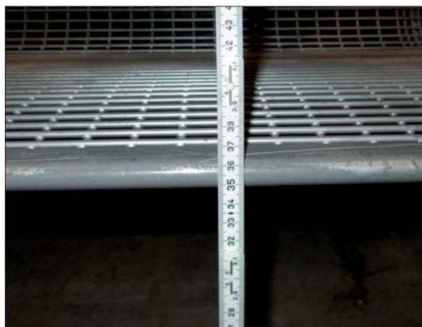
Abbildung 12: Rund 10 cm niedriger als die geforderten 45 cm sind die Sitzbänke im Unterstand von Bad St. Peter-Ording installiert worden.
