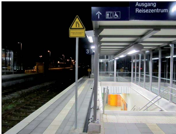
Abbildung 5: In Rendsburg wurde der schmale Bahnsteigbereich durch das Aufstellen eines eigenen Mastes für die Engstellenbeschilderung noch kleiner.
