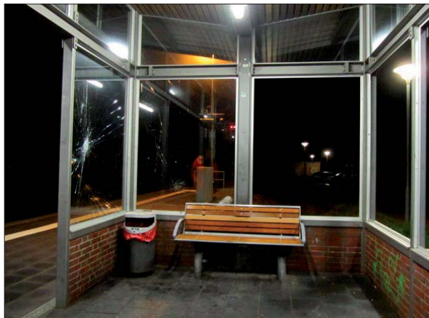
Abbildung 23: Die größten Vandalismusschäden wurden in der Wartehalle von Lensahn registriert. Hier fehlten 6 Scheiben, und 5 Scheiben waren beschädigt.
