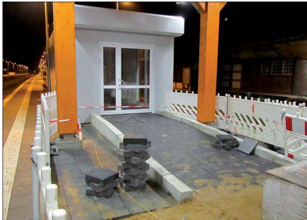
Abbildung 55: Der Höhenunterschied zwischen dem neuen Bahnsteig in Niebüll und dem zukünftigen Warteraum im neuen Container wird mit dem Bau einer Rampe ausgeglichen.
