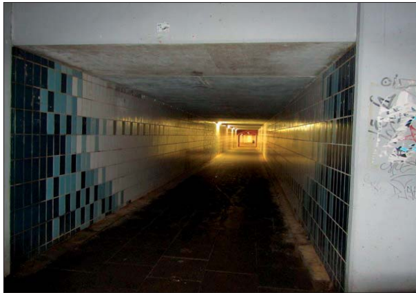
Abbildung 22: In Büchen war die gesamte Tunnelbeleuchtung im Bereich des östlichen Zugangs (Bahnhofstraße) abmontiert worden.
