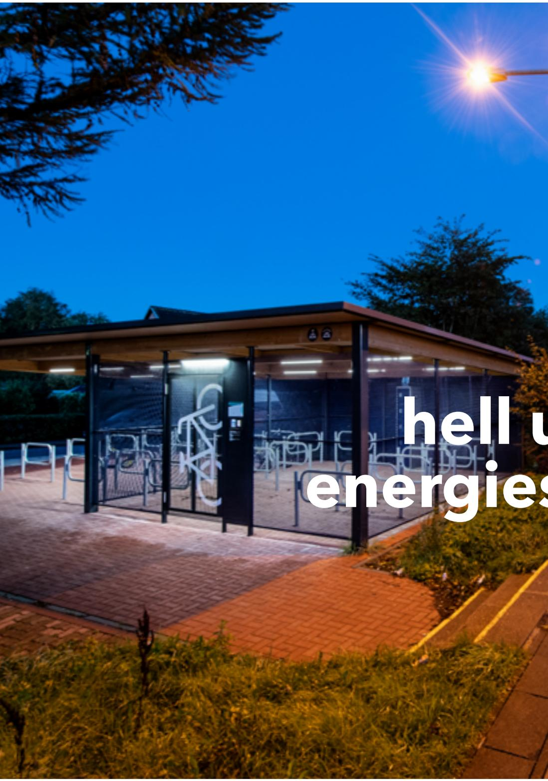
Zur Beleuchtung werden **LED-Leisten** in die Holzträger des Daches und über der Tür eingelassen. Diese werden durch einen **Bewegungssensor** aktiviert und leuchten die Anlage vollständig aus.
