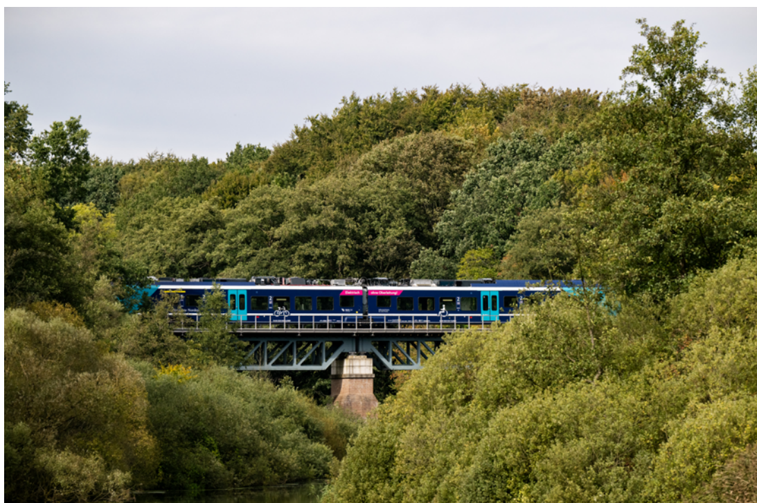
Fahrt eines Akkuzugs über die Schwentinebrücke nach Kiel-Oppen- dorf
