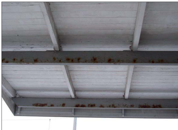
Abbildung 7: Die Träger der Bahnsteigdächer in Itzehoe weisen zunehmend Korrosionsspuren auf.
