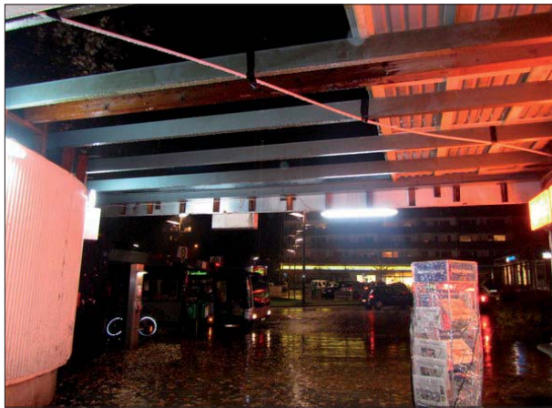
Abbildung 49: In Krupunder wurde mehr als die Hälfte des schon seit längerem beschädigten Daches im Eingangsreich abgebaut.
